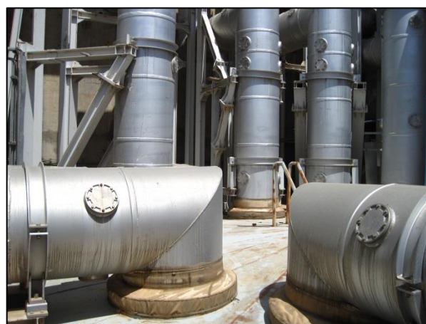
شکل ۳-۸-۱۵- باس داکت‌های بین ژنراتورها و ترانسفورماتورها
