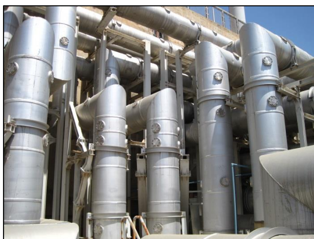
شکل ۳-۸-۱۵- باس داکت‌های بین ژنراتورها و ترانسفورماتورها
