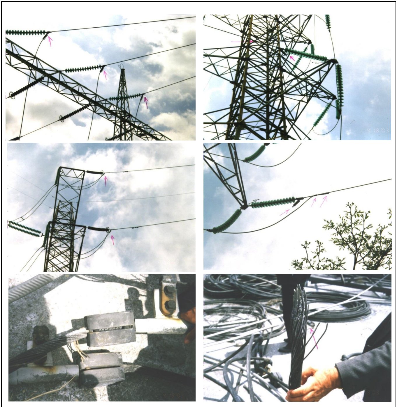
شکل ۳-۲۱-۶- وجود نقص و ذوب شدگی در اتصالات خطوط منتهی به پست ایرالکو
